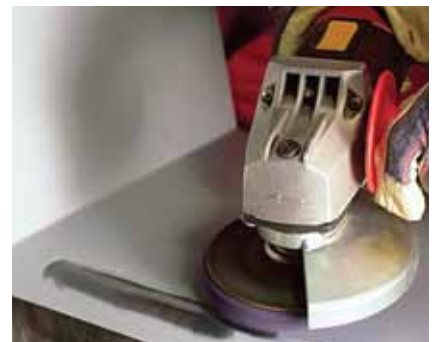
Odstranjevanje starega premaza
